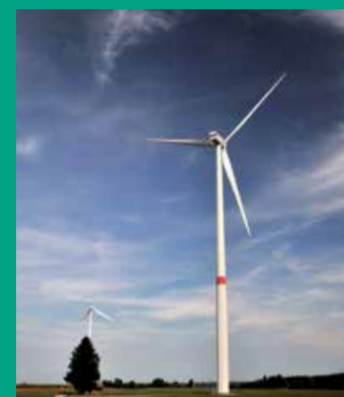
Auch die Energieerzeugung aus erneuerbaren Energien wird ein Thema des Klimaschutzkonzeptes sein. Im Bild die beiden Windkraftanlagen bei Menhofen, Gemeinde Denklingen.
